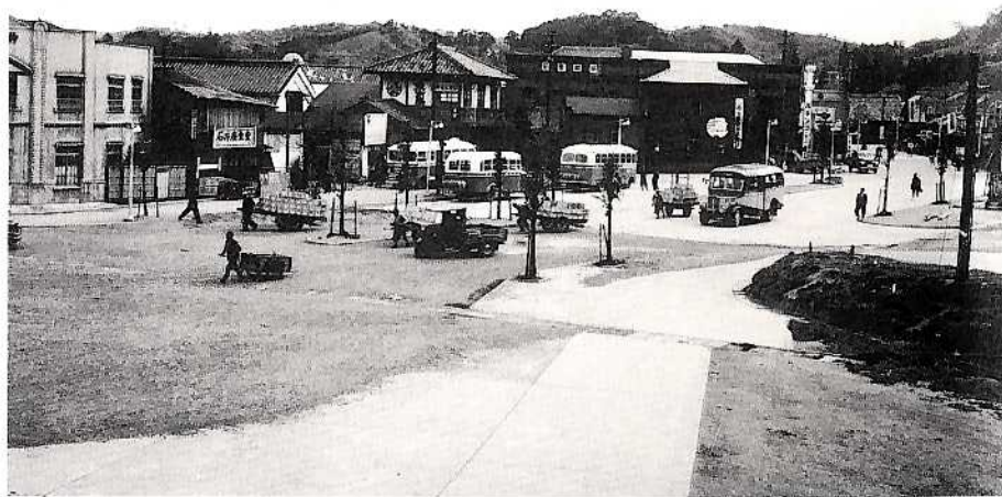
白河駅前コンクリート舗装
