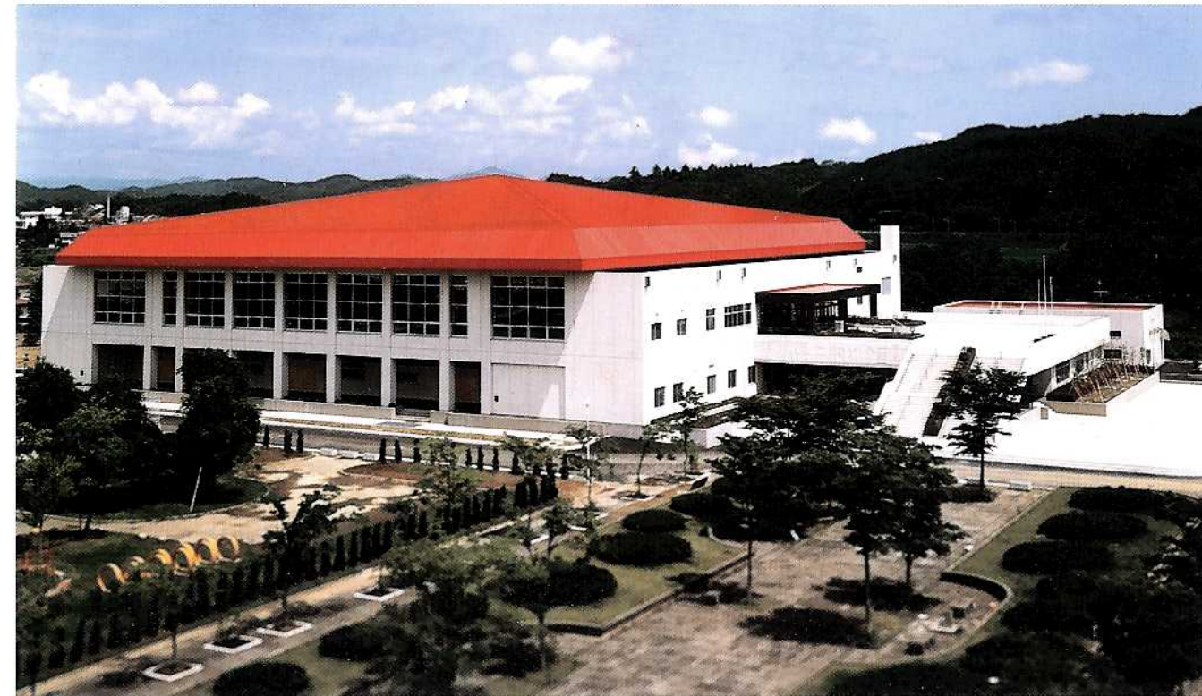
県営体育館（JV）
