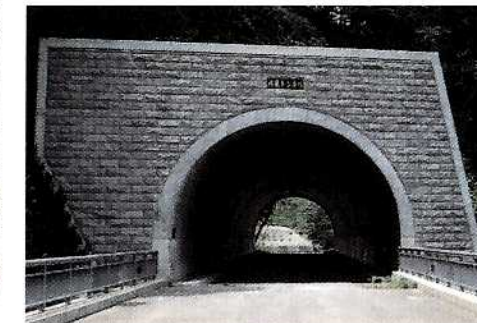
片見トンネル
