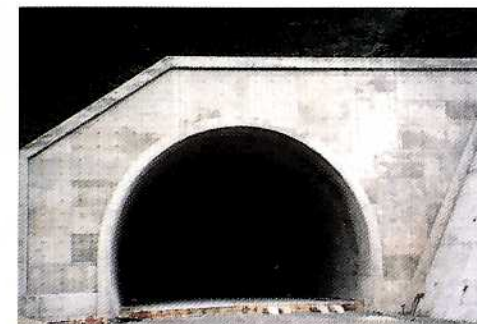
安心坂トンネル
