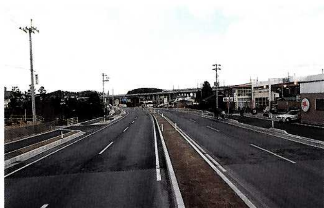
国道4号線拡幅工事
