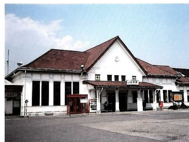
JR白河駅（屋根及外壁工事）
