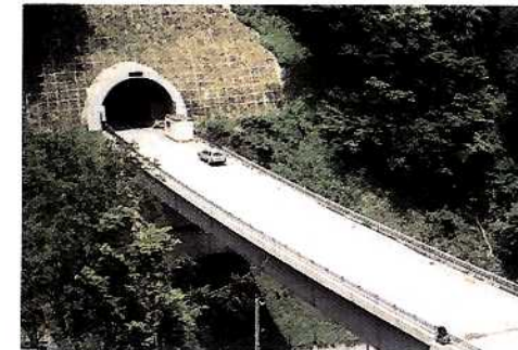
黒石トンネル
