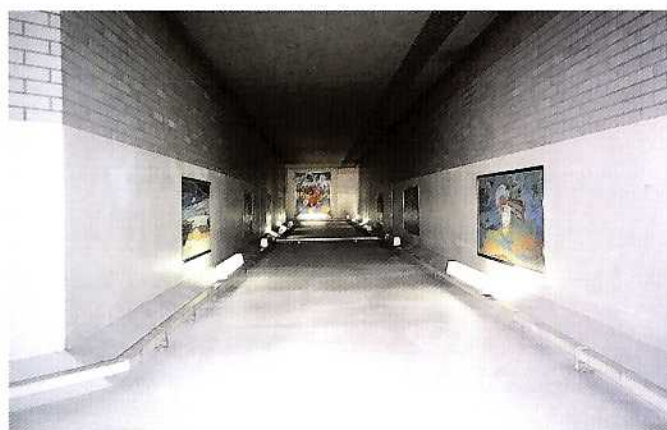
国道4号、和尚壇地下歩道
