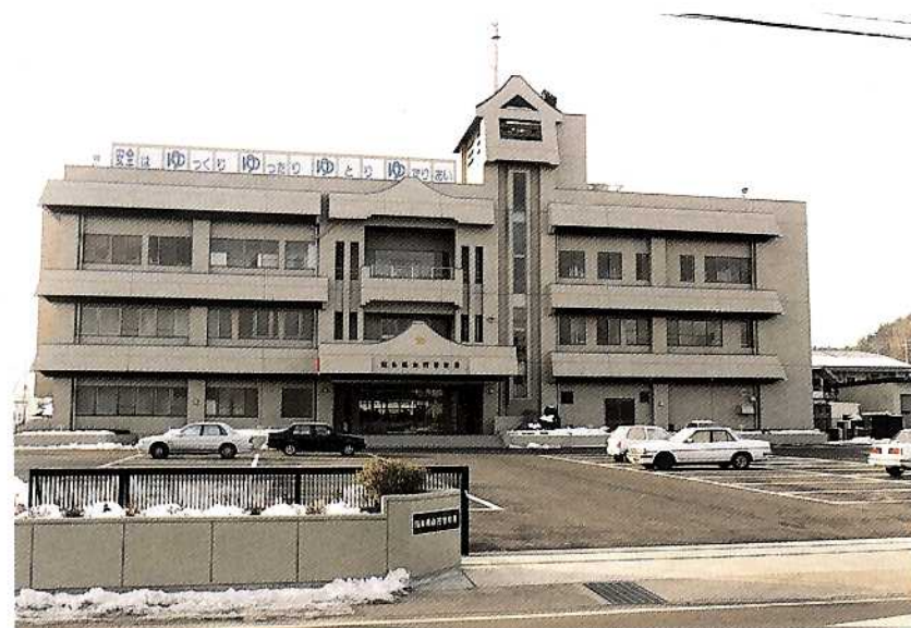
白河警察署（現在）平成5年完成
