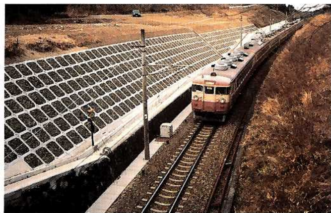
JR土留工事
