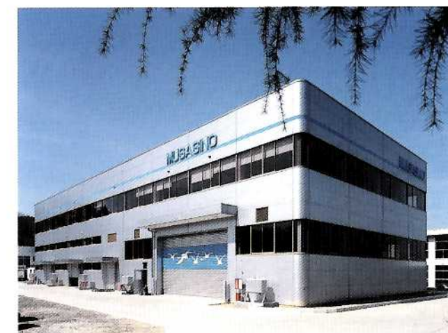
工場および厚生棟
